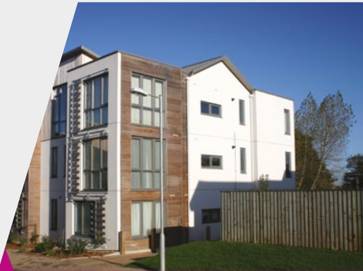
Mehrfamilienhaus Darmstadt, Germany
