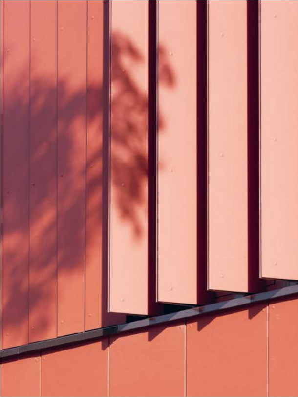
foundation 5+ architekten BDA, Germany; Foitzik Krebs Spies Partnerschaft mbB; SPRENGWERK, Architektur und Sanierung
